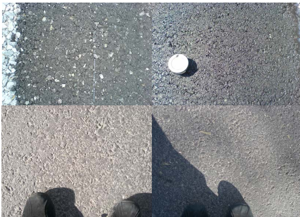
Figur 12. Tjusebotorp-Fagermon. Övre delen: i samband med läggning. Undre delen: efter 3 månader. Vänster: massa från ångturbo. Höger: massa tillverkad i fast verk vid 100 °C. Bilderna är inte tagna vid samma plats
